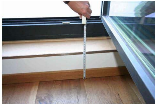
Schwelle und Türrahmen westliche Räume
