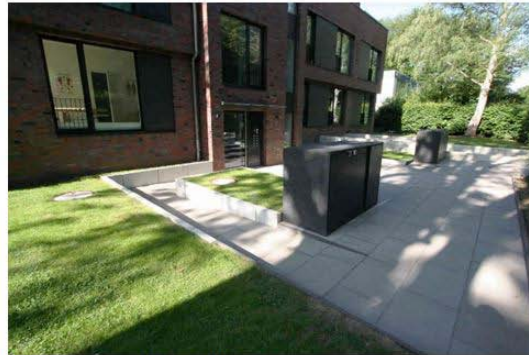
Rampe zum Hauseingang
