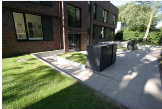
Rampe zum Hauseingang
