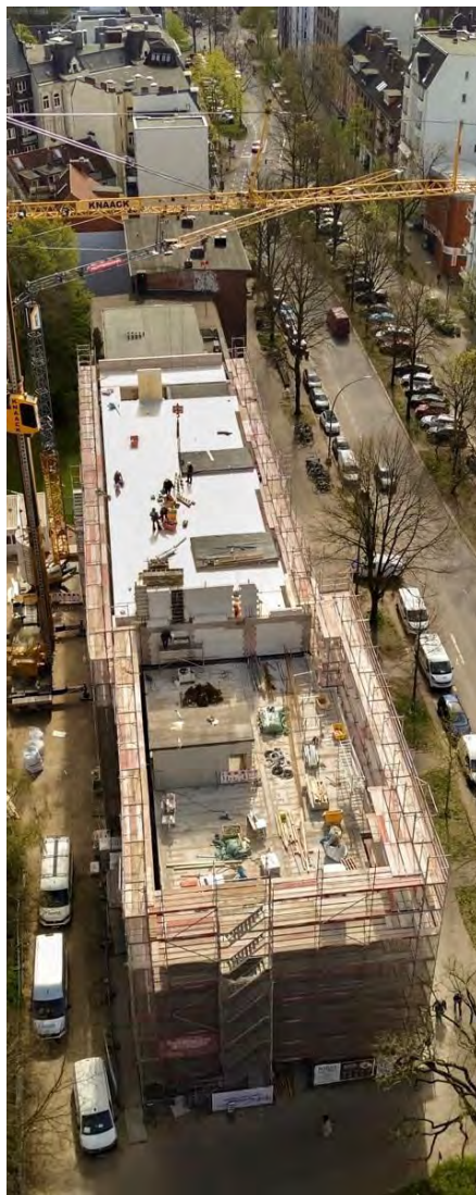
Aufstockung in Holzbauweise.
