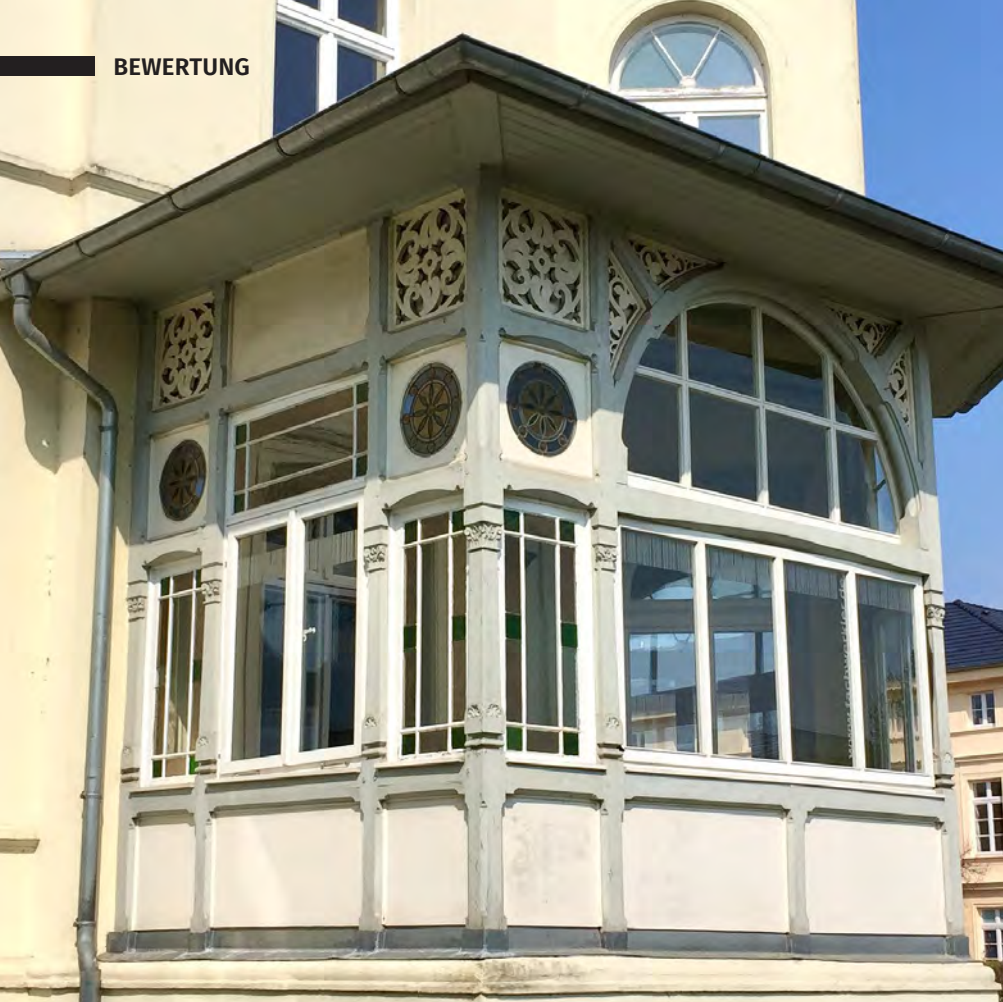
Verglast, überdacht oder offen: Die bauliche Ausführung spielt bei der Wohnflächenberechnung eine entscheidende Rolle.
